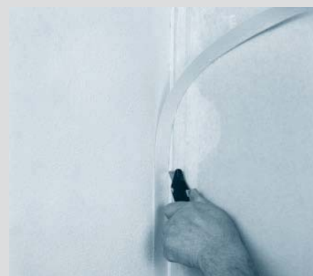
6. Nakon sušenja treba odrezati višak razdjelne trake
