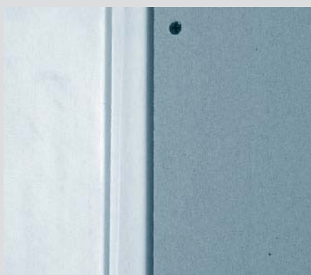
4. Knauf ploče se montiraju s razmakom od 5 mm prema traci
